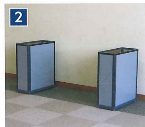
2 サポートを開き、床フレームに乗せる
