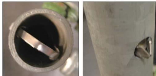
支柱の先端部分にある図のような穴に支柱ジョイントを差し込み支柱同士を連結させます。
