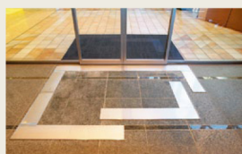
①フレームユニットを設置。
