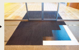
③タイルマットをはめ込んでいきます。
