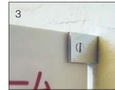
しっかりと締め付けが終わったら施工完了。緩みが無いか定期的に締め付けを確認する。
