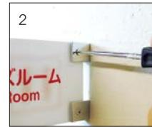
ピクトサインの穴に受けねじとオスねじを嵌合させマイナスドライバーで両側から締め付ける。
