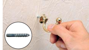
ハンガーボルトフックの取付方法
